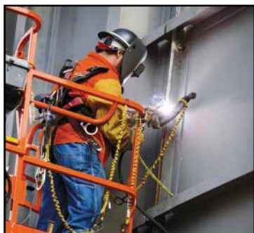
STEPHEN SMALL DEL LOCAL 40 suelta una costura en la "piel" de una unidad HRSG en la nueva planta de turbina de gas de ciclo combinado del TVA en Kentucky occidental. Kiewit es el contratista para el proyecto.
