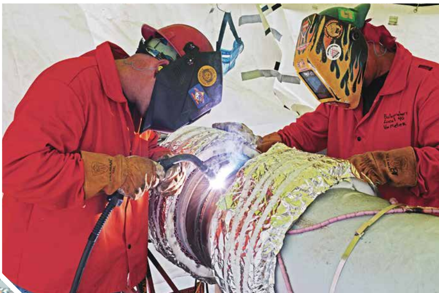
MIEMBROS DEL LOCAL 40 JARROD SMITH, IZQUIERDA, Y WILLIAM VAN METER sueldan secciones de encabezado de vapor.
