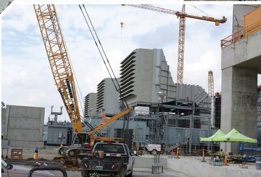
CASAS DE FILTRO DE TURBINA EN FORMA DE TIPO persiana traen el aire exterior para la combustión con gas natural.
